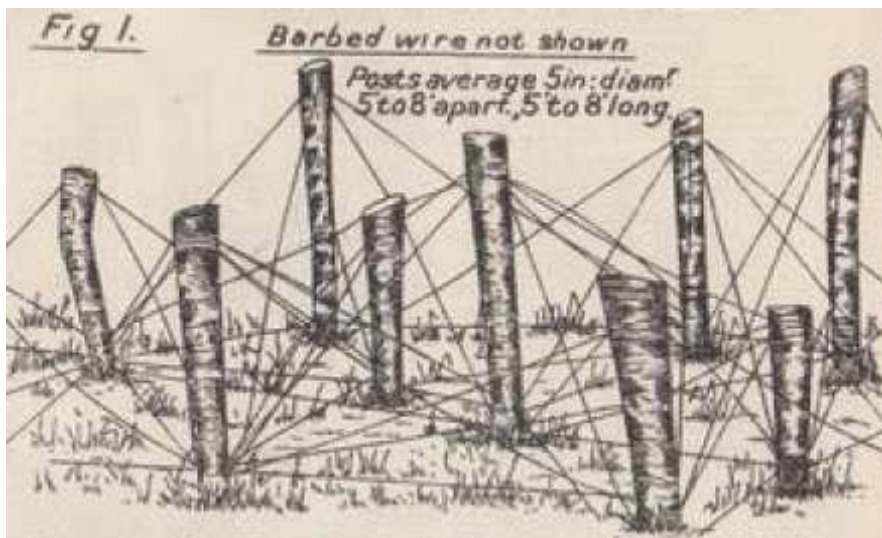
Obr. 35: první dvě fáze stavby překážky z ostnatého drátu
