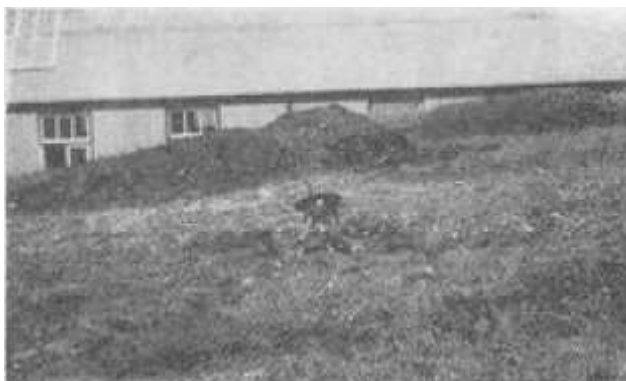
Obr. 3: Čelní pohled na kruhový kulometný okop
