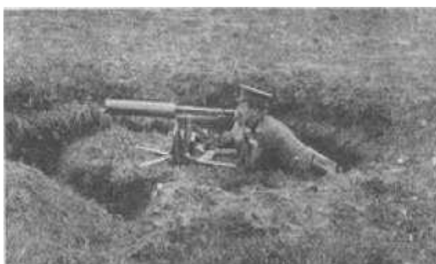
Obr. 4: Pohled dovnitř okopu
