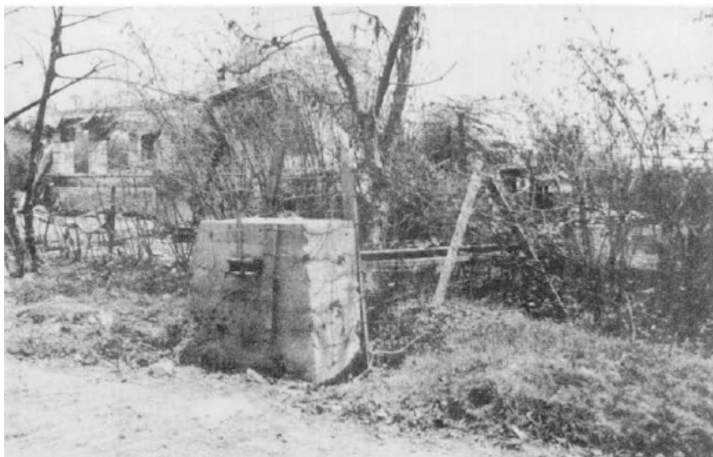
Obr. 26: Kolejový zátaras ukotvený v betonové zídce
