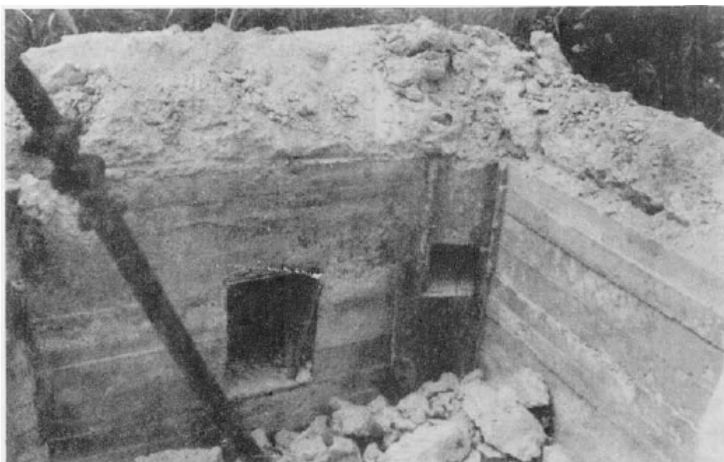
Obr. 29: Schéma a fotografie betonové pevnůstky vybudované u dálnice č. 1
