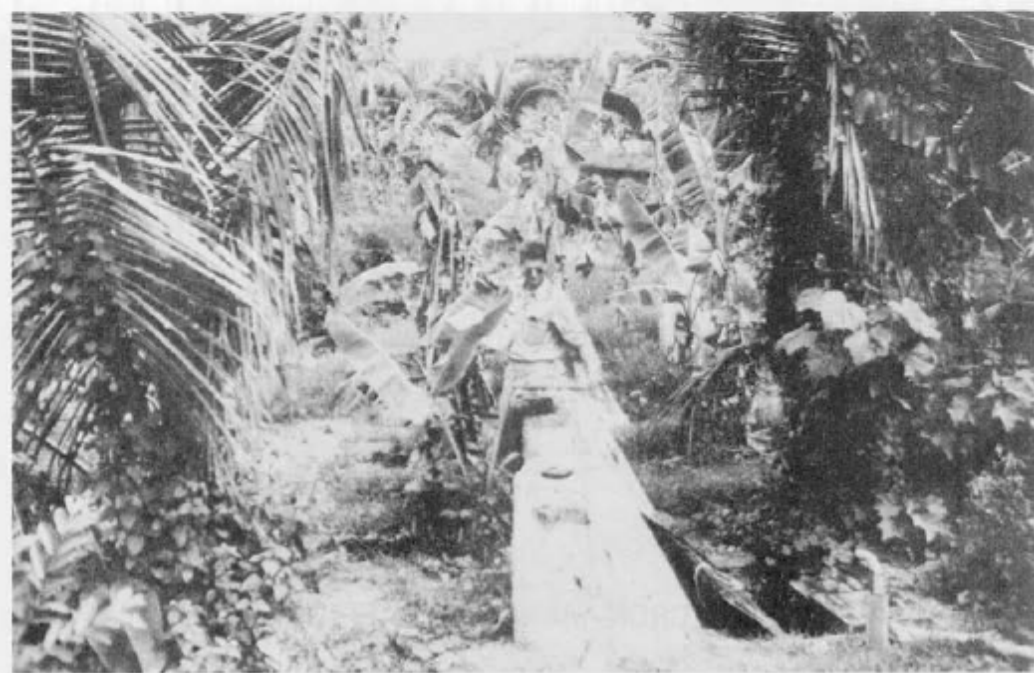
Obr. 21: Odstřelený most přes řeku Mananga a snímek „dračích zubů“ vybudovaných poblíž něj
