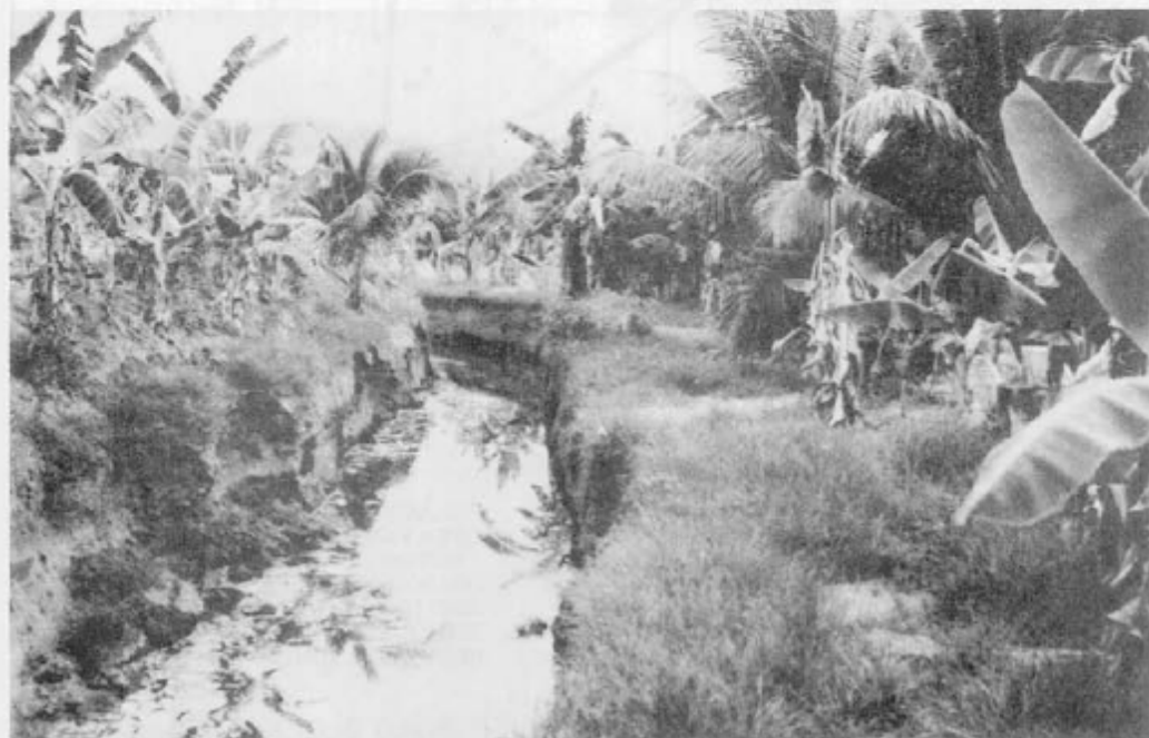
Obr. 20: Řez a pohled na typický protitankový příkop u mostu přes řeku Mananga
