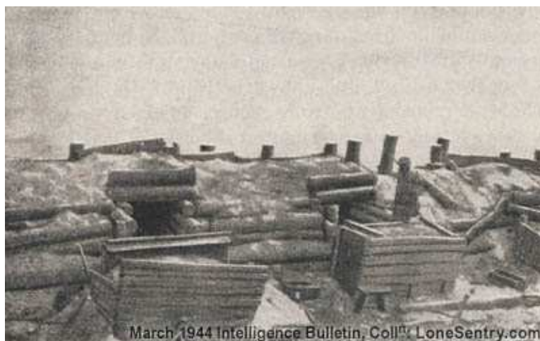
Obr. č. 5: Stejná bojová stanoviště jako na obr. č. 4 při pohledu z týlu. Vchody jsou proti vniknutí tlakové vlny chráněny stěnou.
