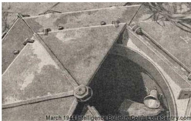
Obr. 21: Detail otvoru pro pozorovatele ve stropnici pevnůstky. Otvor se uzavíral šesti odklápěcími trojúhelníkovými poklopy. Každý segment mohl být odklopen samostatně. V pravém dolním rohu je vidět vyústění trubkového zvukovodu. Prostor mezi kruhovým a šestiúhelníkovým lemem otvoru pro pozorovatele je vyplněn pískem.
