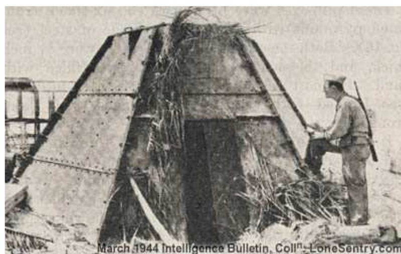
Obr. 20: Vchodová partie ocelové pevnůstky
