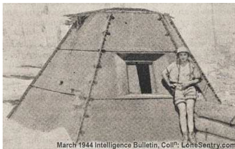
Obr. 19: Ocelová prefabrikovaná pevnůstka. Voják se opírá o stěnu se střílnou. Vlevo je vidět pozorovací štěrбина.
