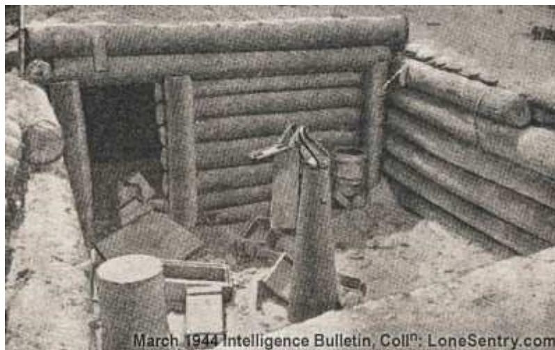
Obr. č. 23: Palebné postavení (druhý výše popsáný typ) pro protiletadlový kulomet ráže 13 mm. Uprostřed okopu se nachází pivotová lafeta, vlevo je vchod do úkrytu.
