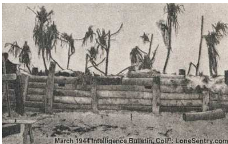
Obr. č. 4: Bojová stanoviště střelců z pušky nebo lehkého kulometu zabudovaná do pobřežní hráze
