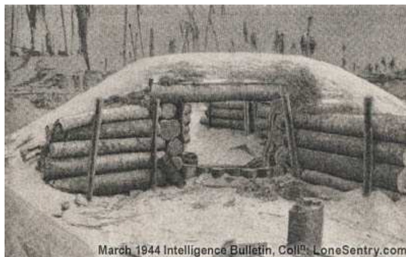
Obr. č. 26: Dřevozemní pevnůstka pro kanón (ostrov Betio)
