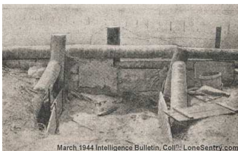
Obr. č. 6: Pohled z týlu na postavení pro střelce z pušky nebo lehkého kulometu. Palebné postavení je zabudováno do pobřežní hráze.
