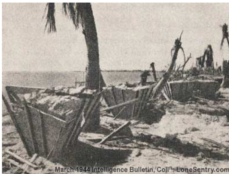
Obr. 35: Nedokončené překážky z betonových komolých jehlanů. Beton je nalit v bednění. Překážka je „vzhůru nohama“.
