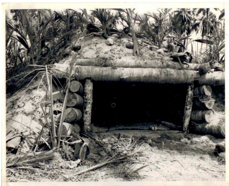
Obr. 48: Střílna pevnůstky pro kanón ráže 75 mm
