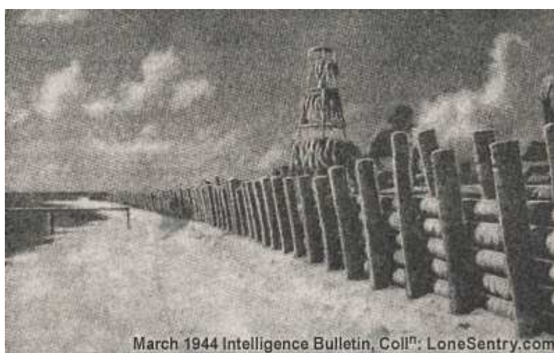
Obr. 38: Pobřežní stěna bez zabudovaných palebných stanovišť
