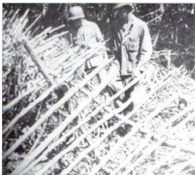
Obr. 34: Protipěchotní překážka z naostřených bambusových kolíků
