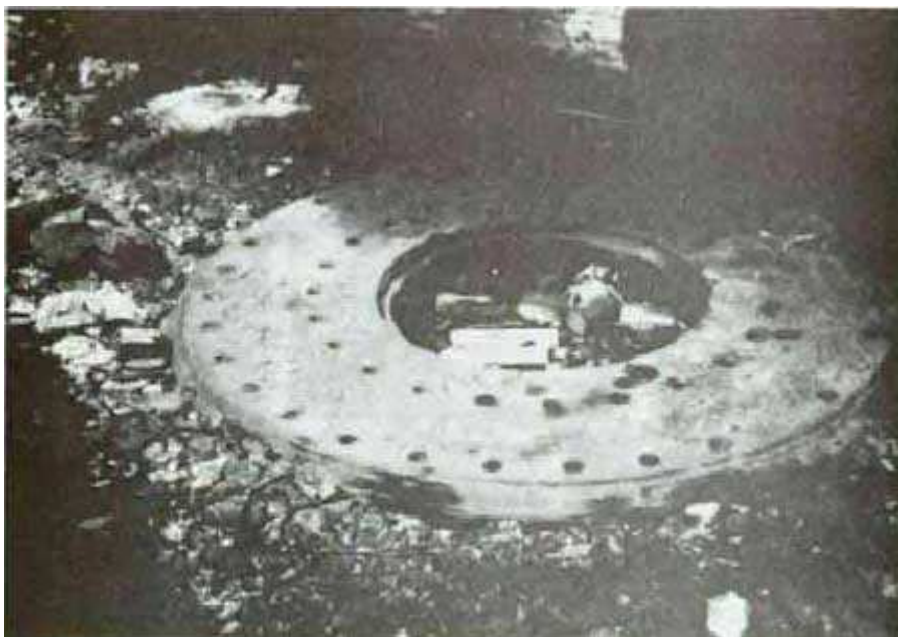
Obr. 15: Ocelový základ pro upevnění námořního děla ráže 20 cm (1984)
