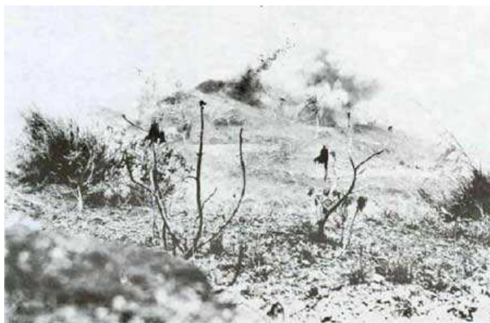
Obr. 51: Snímek pořízený během demolice japonských úkrytů na hoře Alifan
