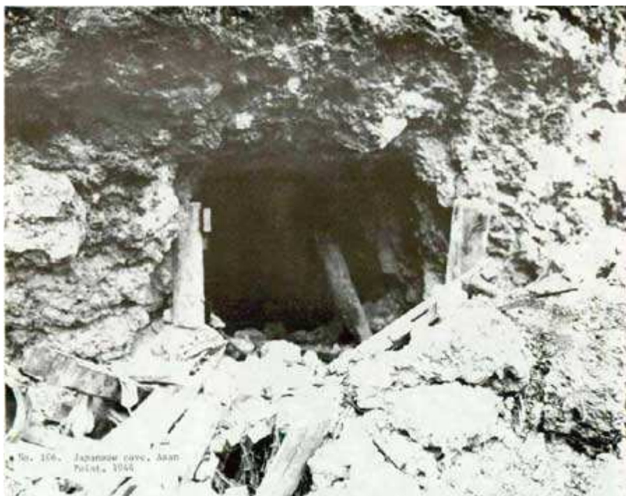
Obr. 22: Vchod do tunelu (objekt č. 106). Stav v roce 1944.
