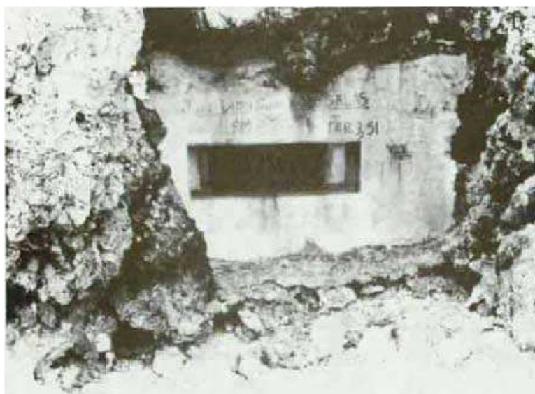
Obr. 48: Stěna s kanónovou střílnou pevnůstky č. 83
