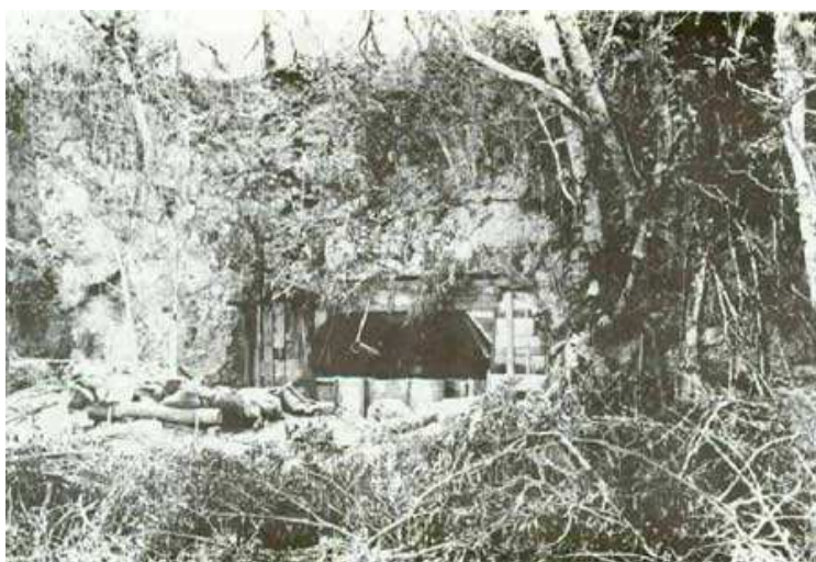
Obr. 19: Stěna se střílnou objektu č. 64. Stav v roce 1944. Zdá se, že ještě nebylo odstraněno bednění.
