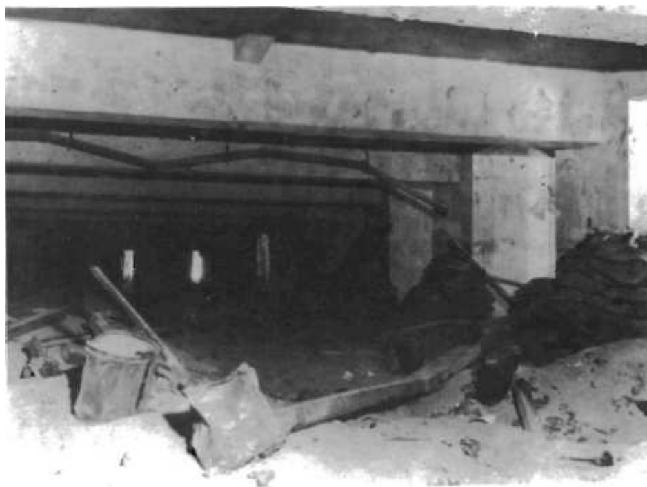
Obr. 1: Přízemí poštovního úřadu. Vpravo je vidět bariéry z pytlů plněných pískem.
