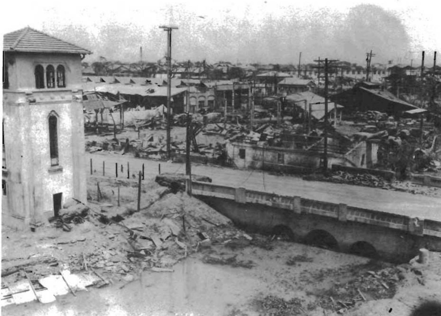
Obr. 10: Bunkr (pravděpodobně stejný jako na obr. 9a, b) na obranu přístupu k mostu. Do bunkru ústí krytý spojovací zákop. Vstup do zákopu se nachází před bariérou z pytlů s pískem postavenou před vchodem do budovy.
