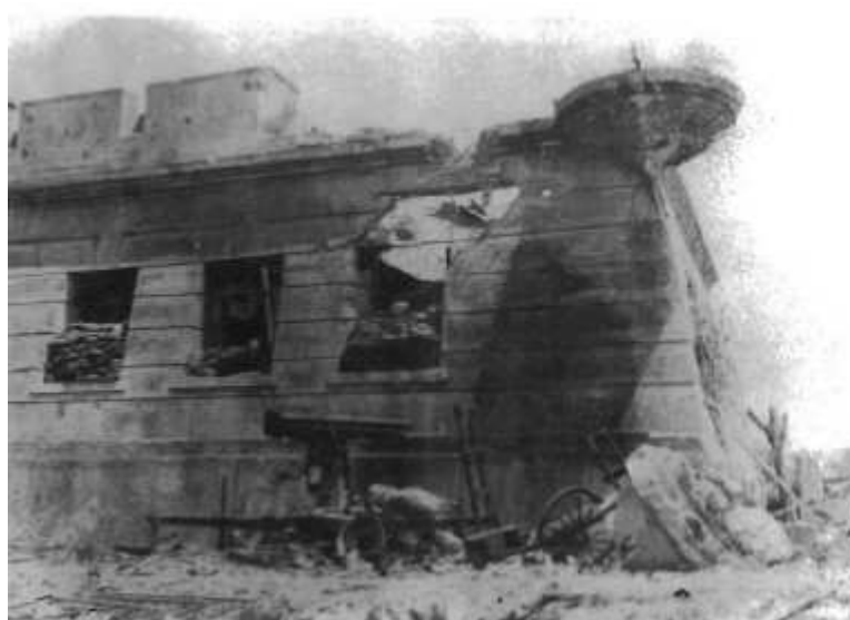
Obr. 3: Pohled zvenčí na opevněnou budovu policejní stanice
