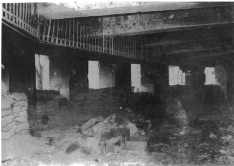
Obr. 2: Pohled do útrob druhého nadzemního patra poštovního úřadu. V oknech jsou naskládány pytle s pískem.
