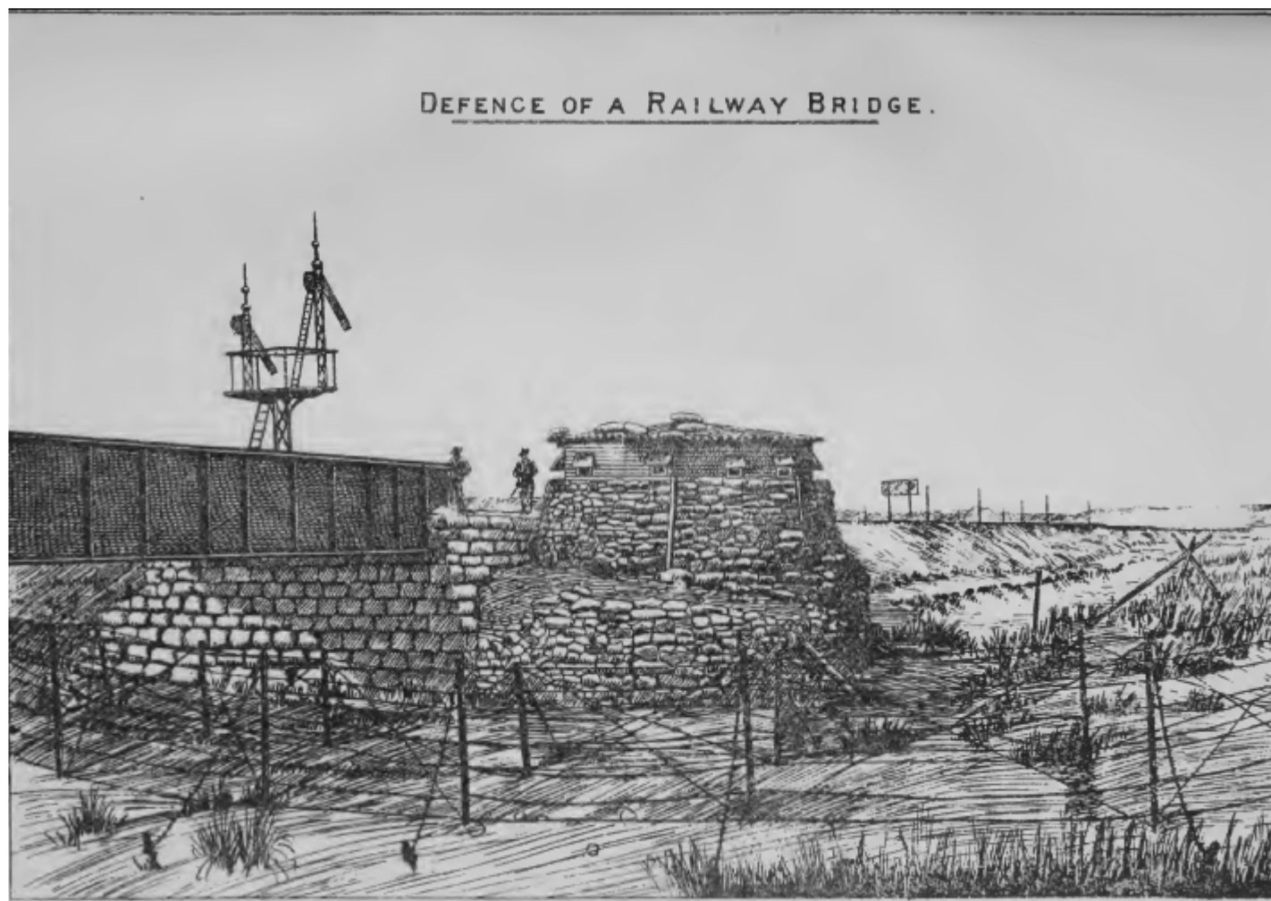
Obr. 23: Blokhaus na obranu železničního mostu
