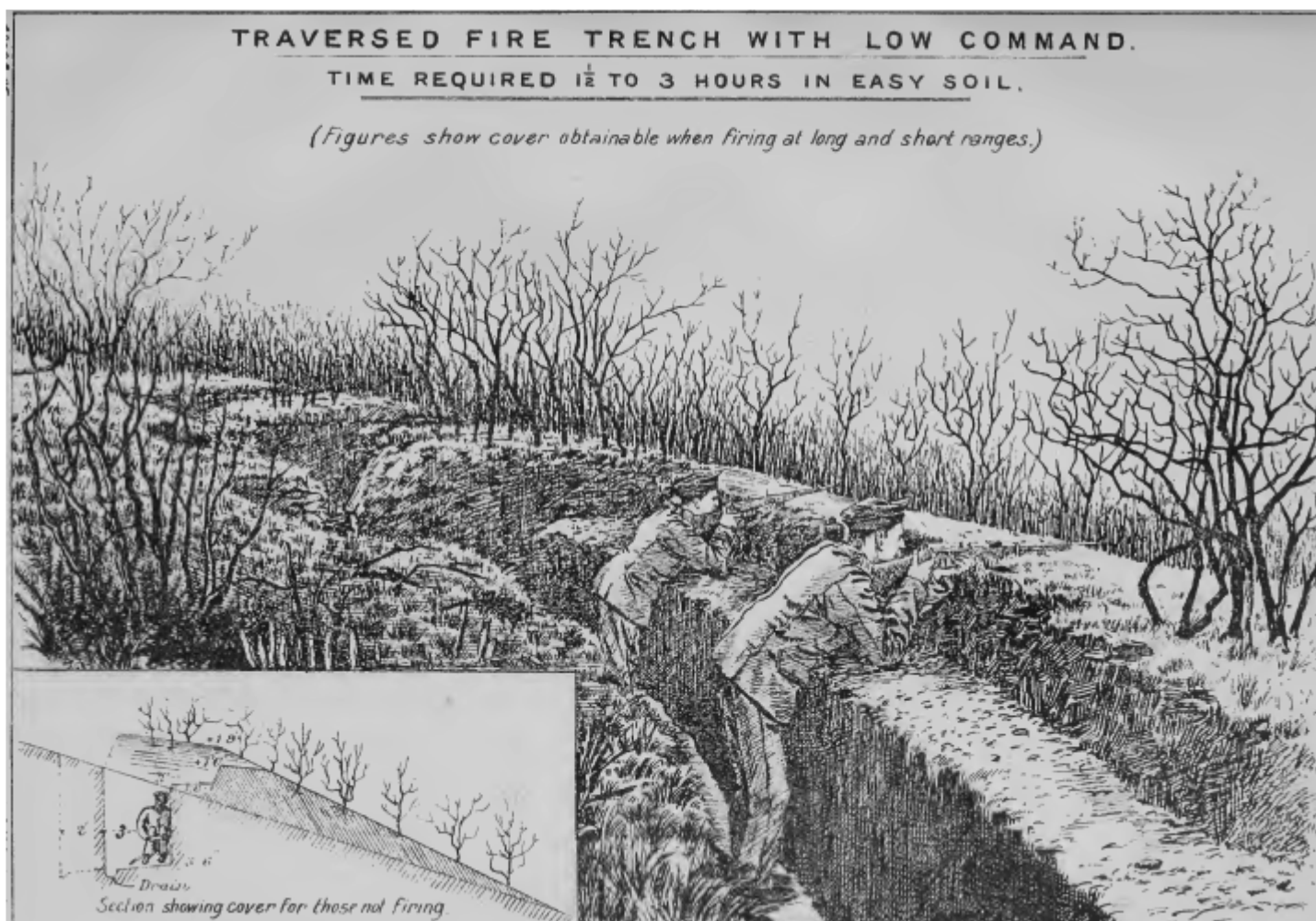
Obr. 3: Střelecký zákop s traverzami
