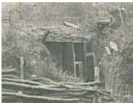
Obr. 2/4: Vchod do úkrytu
