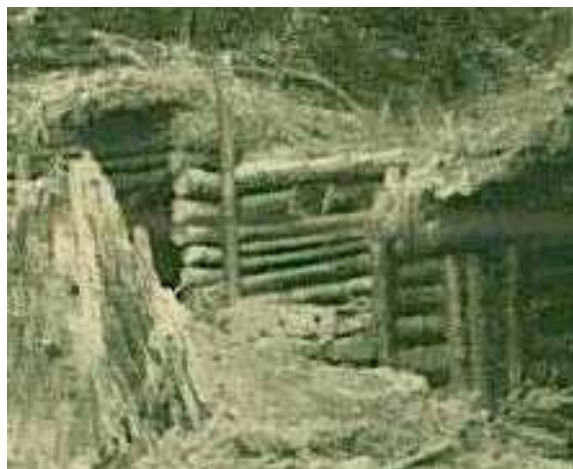
Obr. 4/3: Zpevněná čelní stěna přístupového zákopu
