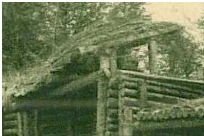
Obr. 4/1: Detail úkrytu se sešikmenou stropnicí (pozorovatelna)
